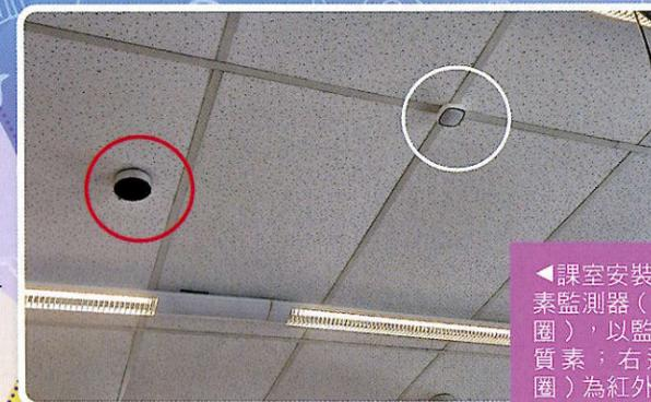
◀ 課室安裝空氣質素監測器 (圖左紅圈)，以監測空氣質素；右邊 (白圈) 為紅外線傳感器，以探測課室使用狀況。
